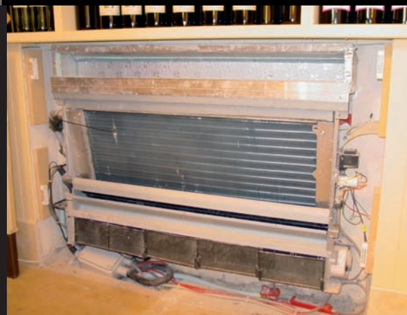
L'INSTALLAZIONE. I ventilconvettori Olimpia Splendid serie Bi2 nel modello Sli 800 hanno risolto il problema delle nicchie: avendo una profondità di soli 126 mm hanno reso quest'opera edile realizzabile.
