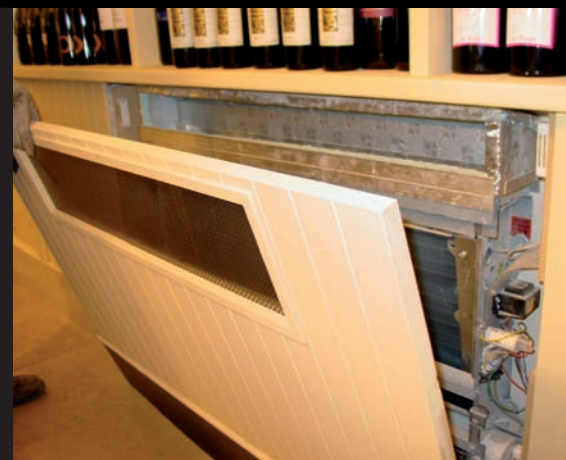
L'INSTALLAZIONE. I ventilconvettori Olimpia Splendid serie Bi2 nel modello Sli 800 hanno risolto il problema delle nicchie: avendo una profondità di soli 126 mm hanno reso quest'opera edile realizzabile.
