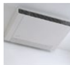
Installazione a soffitto.
